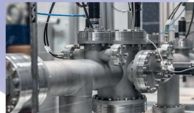
Tratamiento unificado de agua
